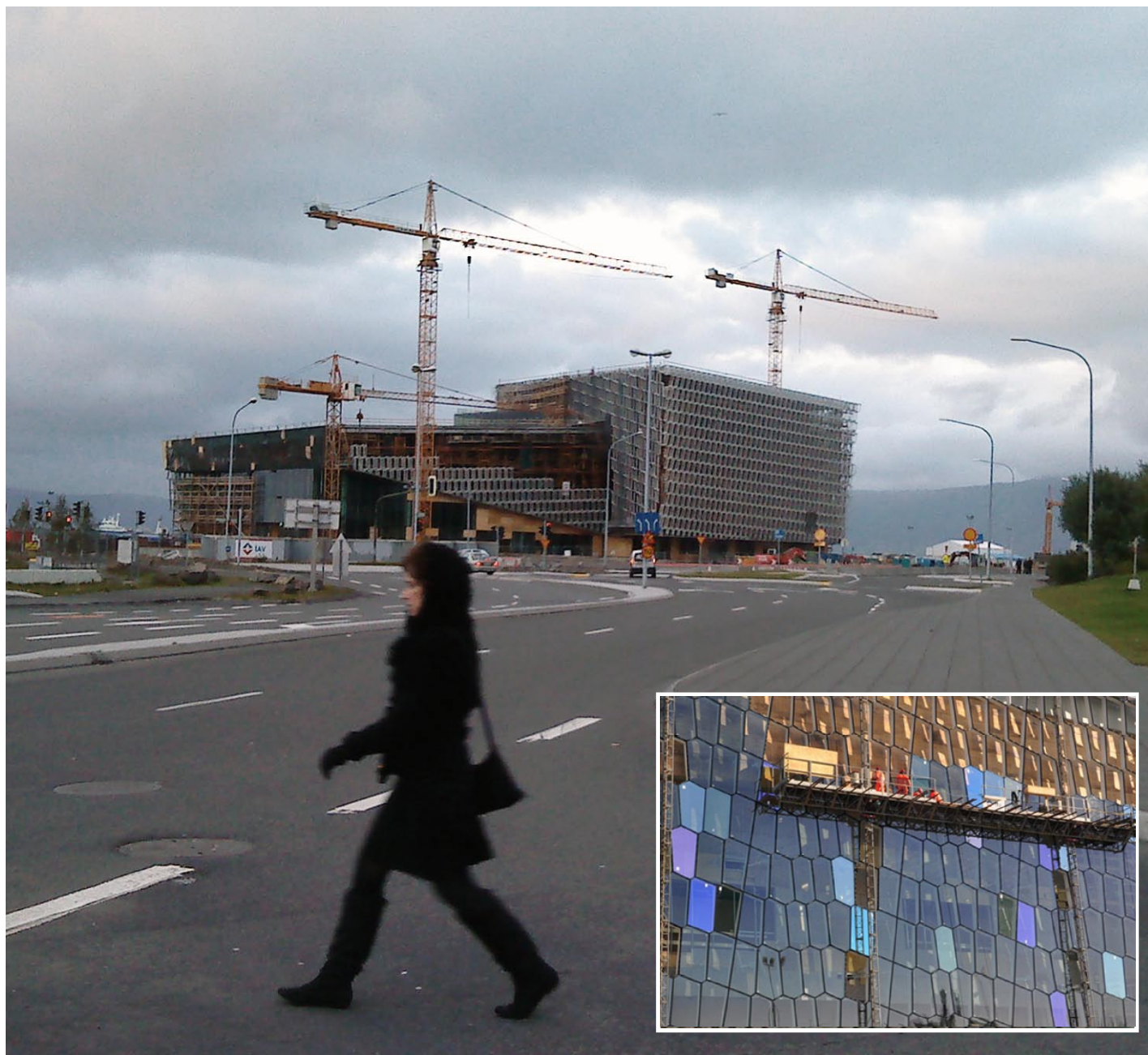
Baustelle der Konzerthalle in Reykjavik im September 2010 und Ausbesserungen an der Südfassade, die dem Wind nicht stand gehalten hatte.
